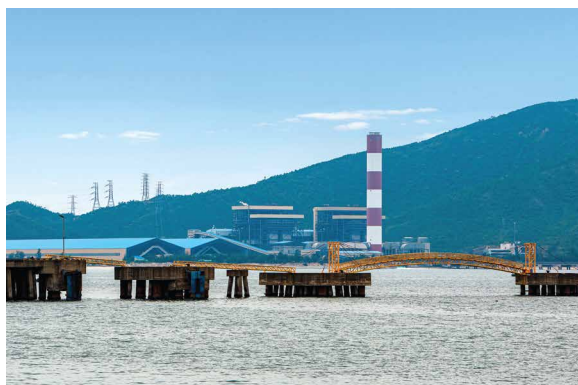
Nhiệt điện Vũng Áng Vung Ang Thermal Power Plant
