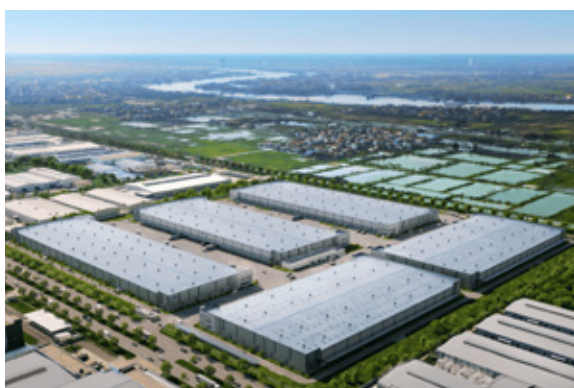
Nhà máy SLP Bắc Ninh SLP Bac Ninh Factory
